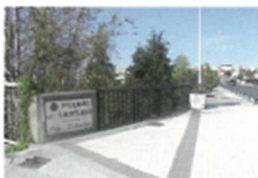
Irún Puente de Santiago
